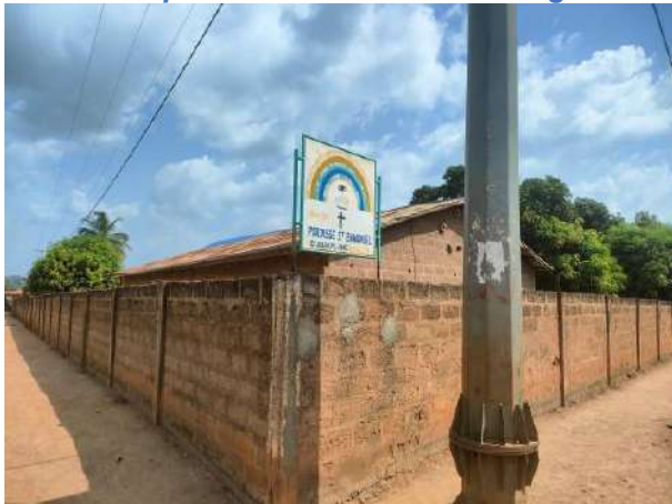
Eglise Céleste à Adakplamé
