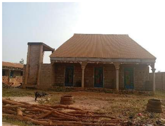
Construction en brique a Olorun shogo
